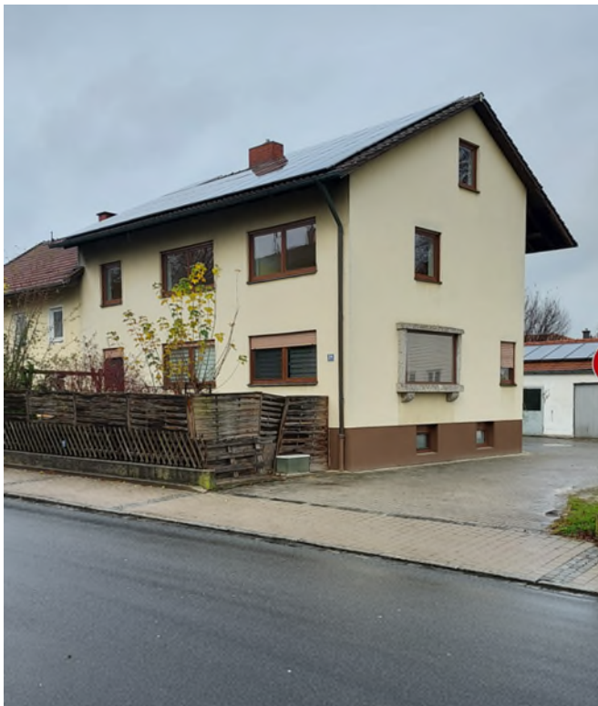
Abbildung 1. Frontenhausener Straße 34 und 36 in Gangkofen
